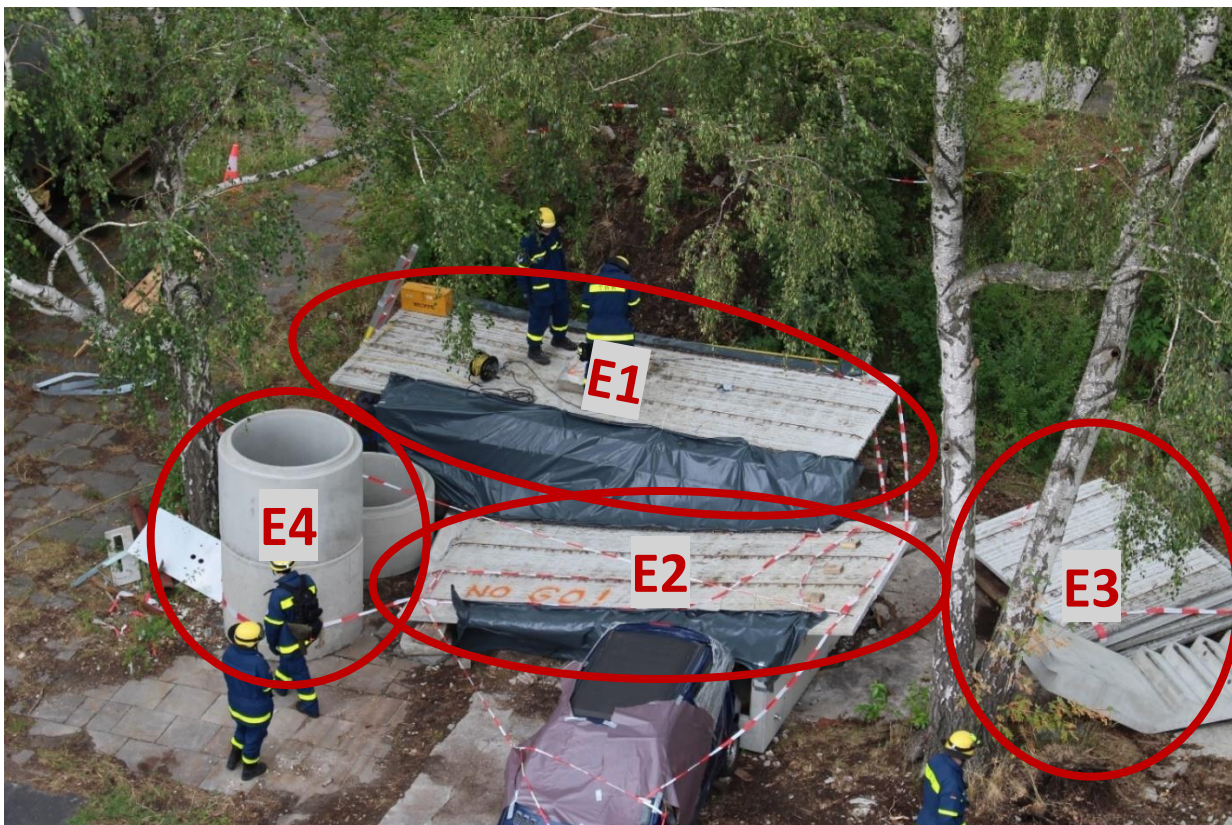
Abb. 4: Übersicht über die Bergungs-Übungsanlage
