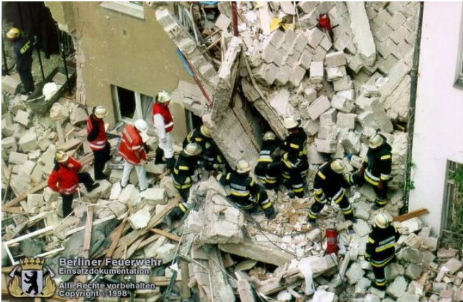
Abb. 1: Gebäudeeinsturz nach Gasexplosion in Berlin (Lepsiusstr.), 1998 Quelle: Berliner Feuerwehr
