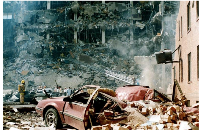
Abb. 2: Gebäudeeinsturz nach Sprengstoffanschlag in Oklahoma City, 1995 Quelle: MSNBC
